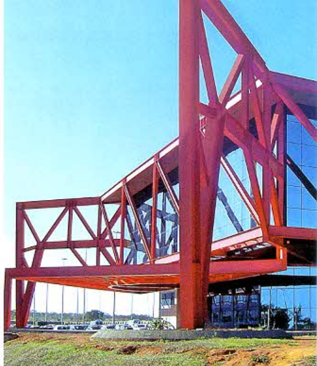
Detalhe das estruturas metálicas de apoio da caixa
